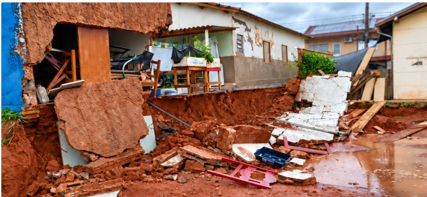
Residência fica parcialmente destruída após o temporal em Avaré, com desabamento de muro e grande volume de lama.
