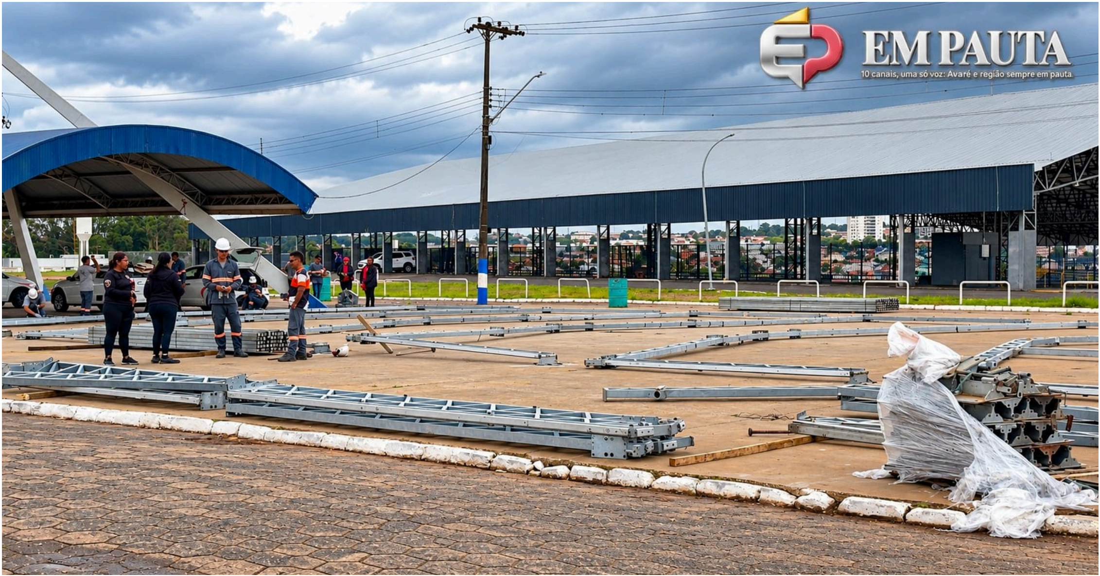
Montagem da estrutura da Faesp Show no recinto da EMAPA, em Avaré.
